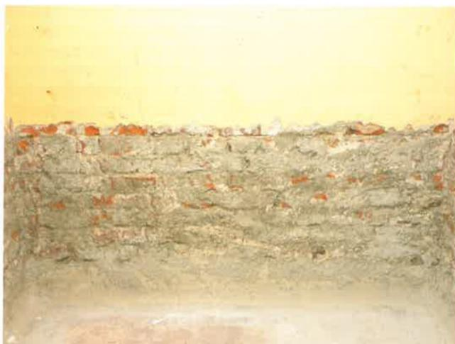
Im ersten Arbeitsschritt mussten alle schimmelbefallenden Putzteile entfernt werden.
